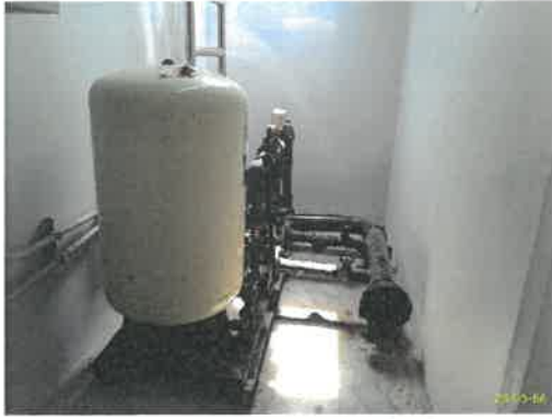
ระบบปั้มน้ำใช้และถังเก็บสำรองน้ำชั้นดาดฟ้า อาคาร 6
