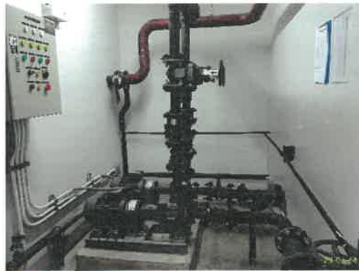
ระบบปั้มน้ำใช้และถังเก็บสำรองน้ำชั้นดาดฟ้า อาคาร 6
